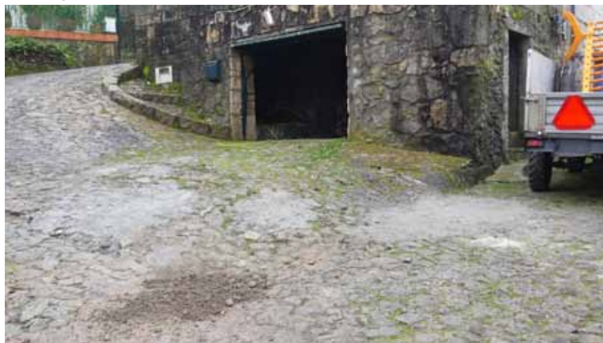
Reparação de rua para permitir o acesso a garagem.
